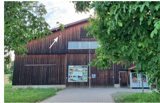
Abb. 3: Die Scheune mit dem in ca. 7 m hohen Flugloch.
